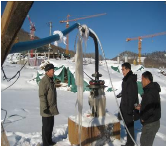
温泉井出水现场
